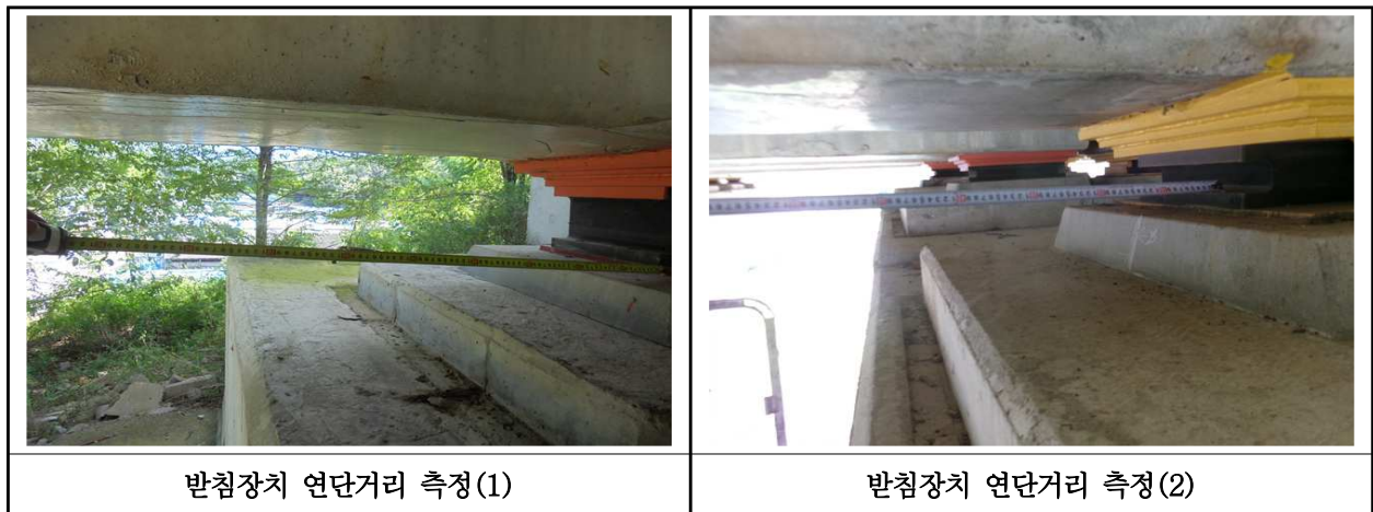
【사진 20.3.14】 교량받침장치 연단거리측정
