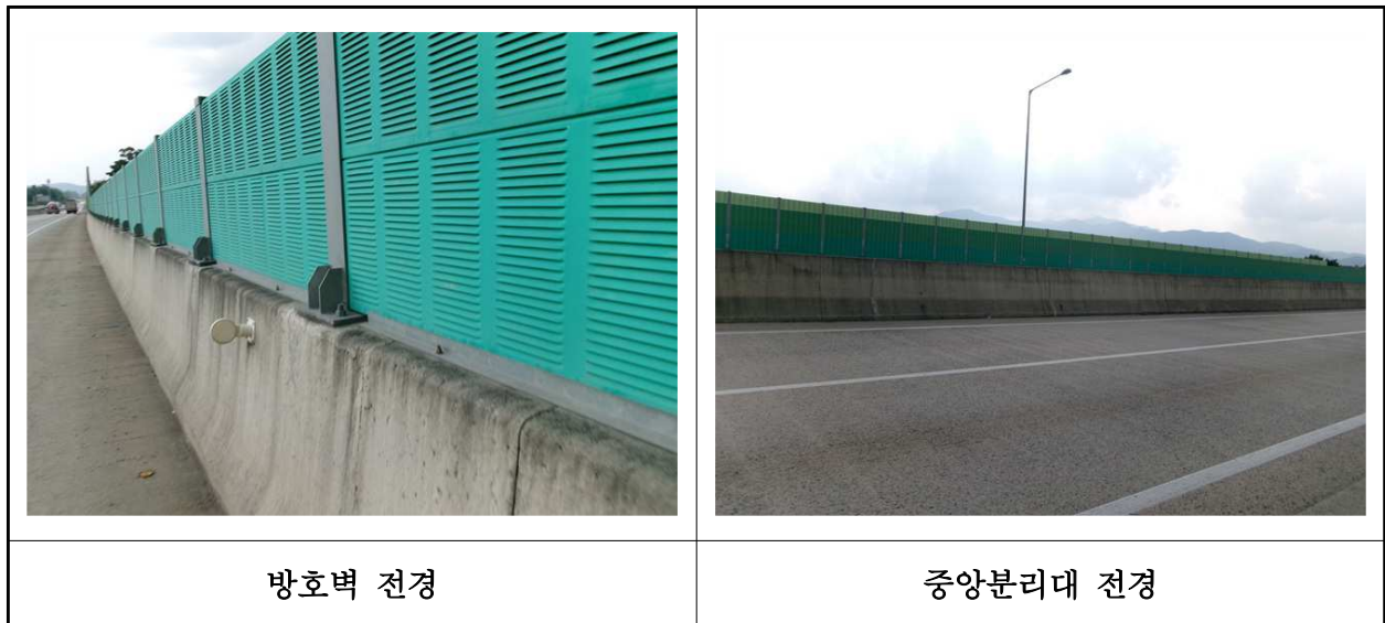
【사진 20.3.23】 방호벽 및 중양분리대 전경
