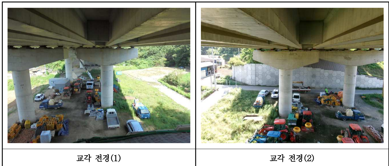
【사진 20.3.10】 교각 전경
