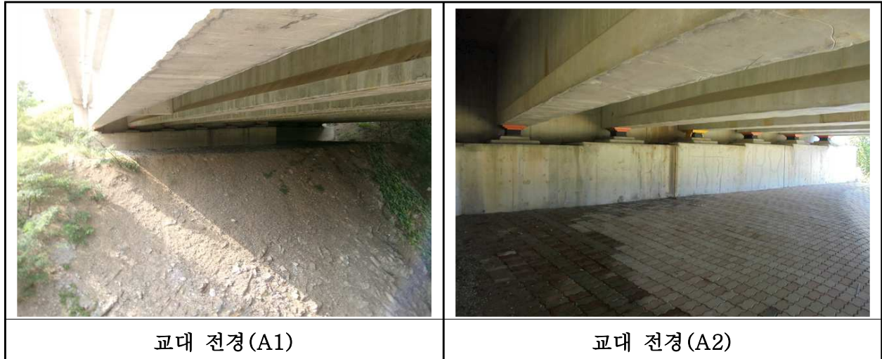
【사진 20.3.33】 교대 전경
