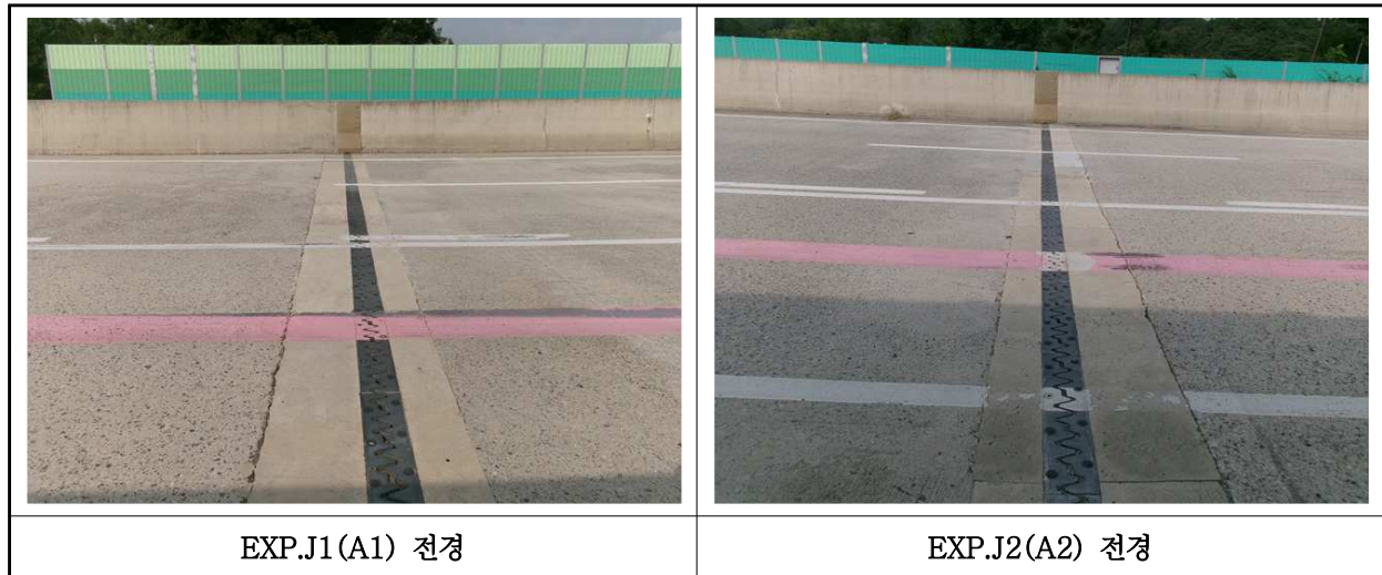
【사진 20.3.41】 신축이음장치 전경
