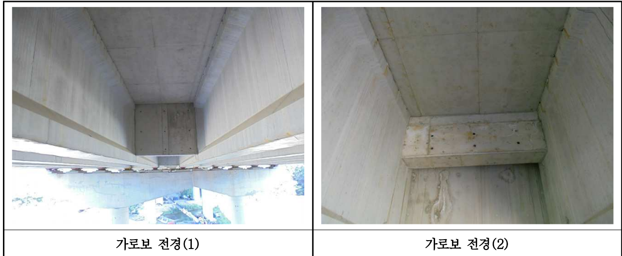
【사진 20.3.31】 가로보 전경
