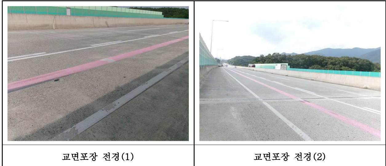
【사진 20.3.44】 교면포장 전경
