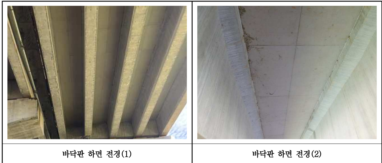
【사진 20.3.2】 바닥판하면 전경
