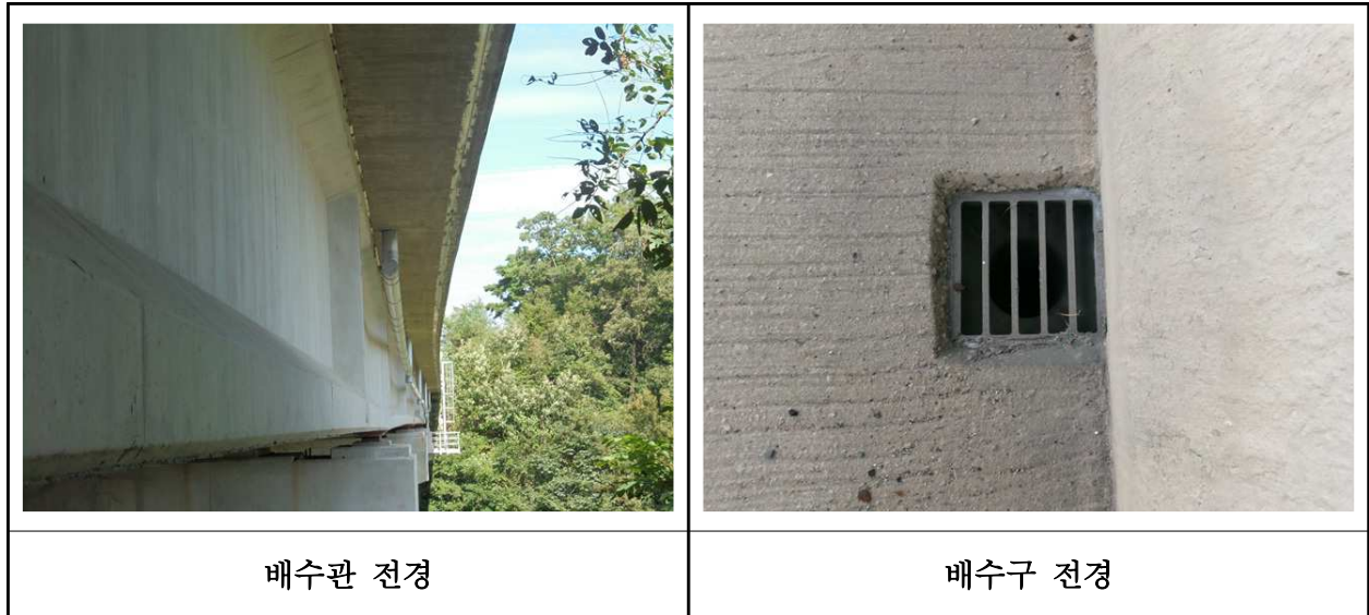
【사진 20.3.21】 배수시설 전경
