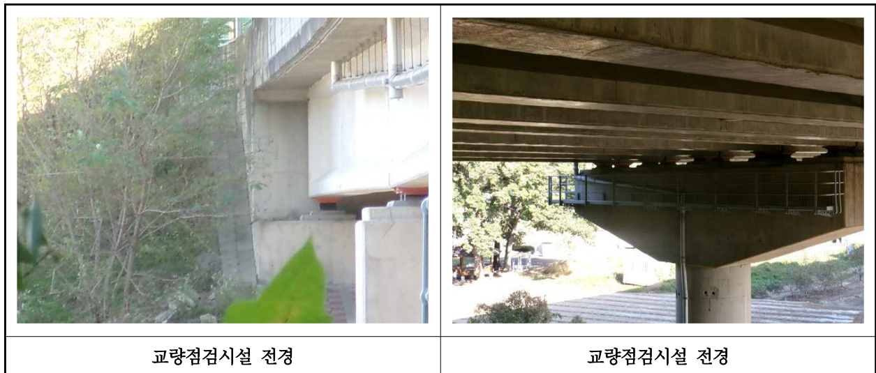
【사진 20.3.25】 교량 점검시설 전경
