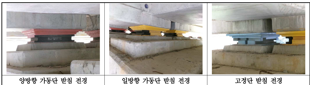
【사진 20.3.12】 교량받침 전경
