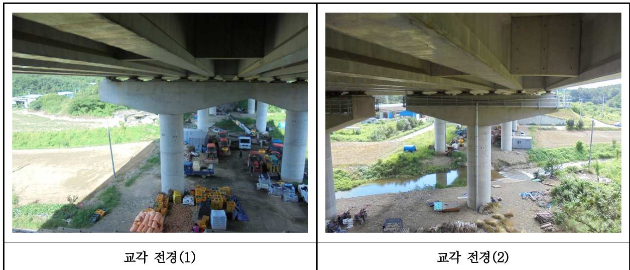
【사진 20.3.35】 교각 전경
