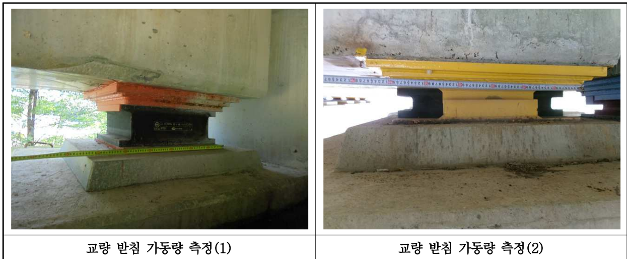
【사진 20.3.15】 교량받침 이동량 측정
