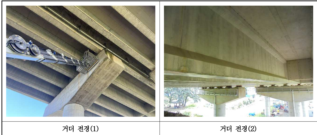
【사진 20.3.29】 거더 전경
